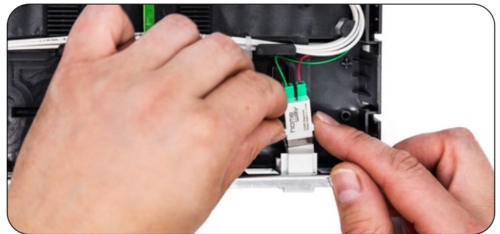
Abb. LC/APC Duplex-Kupplung in Keystone Adapter einstecken und einrasten
