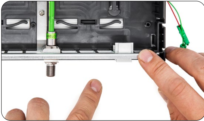
Abb. Keystone Adapter LC/APC Duplex einsetzen
