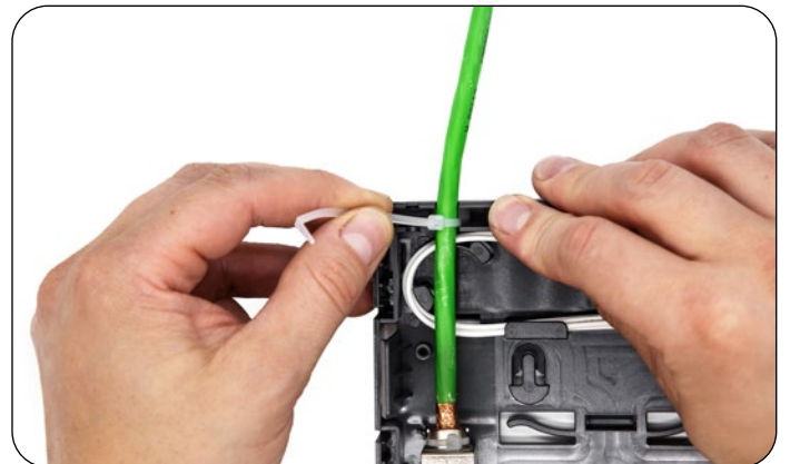
Abb. GREENforMEDIA Kabel mit Kabelbinder befestigen
