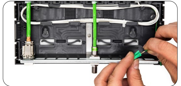
Abb. LC/APC Steckergehäuse anbringen
