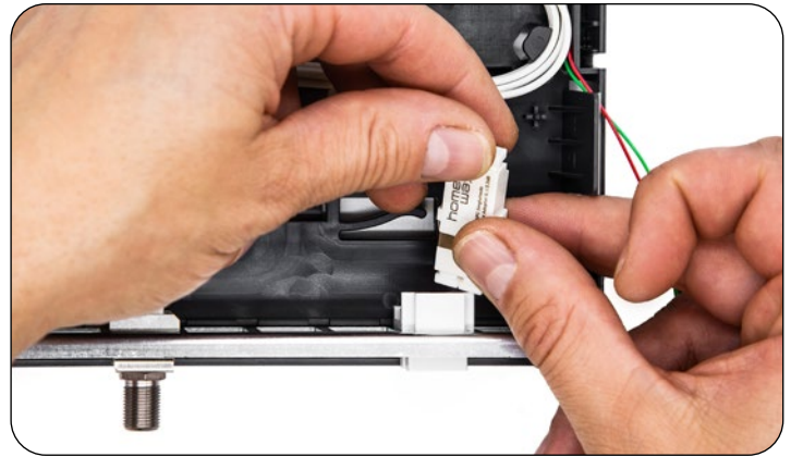
Abb. LC/APC Duplex-Kupplung vorbereiten
