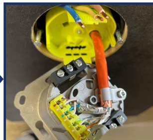
Mit LSA-Plus Montagewerkzeug Adern nacheinander vollständig eindrücken. Farbreihenfolge s.o.
