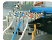
Abb.: Überstehende Adern abschneiden
