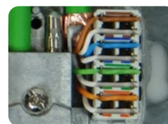
Abb.: Fertig angeschlossene homeway one. Basisdose
