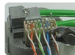
Abb.: Überstehende Adern abschneiden
