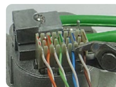
Abb.: Überstehende Adern abschneiden
