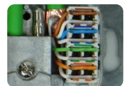
Abb.: Fertig angeschlossene homeway one. Basisdose
