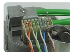
Abb.: Überstehende Adern abschneiden
