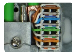
Abb.: Fertig angeschlossene homeway one. Basisdose
