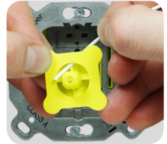
Abb.: Einführen Kabel in Speicherspule
