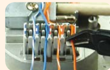
Abb.: Überstehende Adern abschneiden
