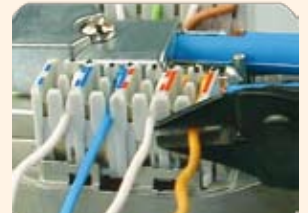
Abb.: Überstehende Adern abschneiden
