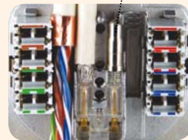
Abb.: Kabel auflegen
